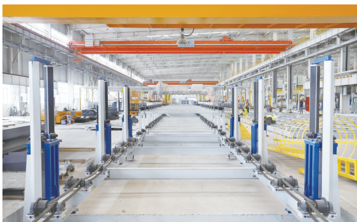
下料中心等离子上料区智能喷码机安装完成
